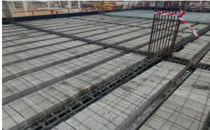
Figure IV. 13 : plancher en corps creux
