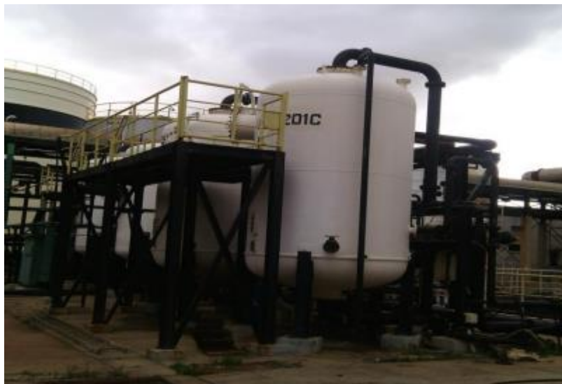
Figure III.3: D'ioniseur prise de la station de dessalement TCD 6-8000. [78]
