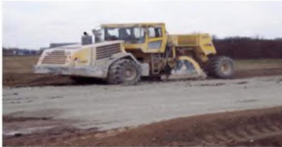
Figure.II.24. Chantier de traitement du sol au ciment. [Douakha.H et al.2018]
