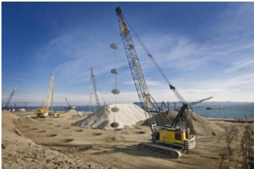
Figure.II.2. Compactage dynamique profond. [Oudni.S.2018]
