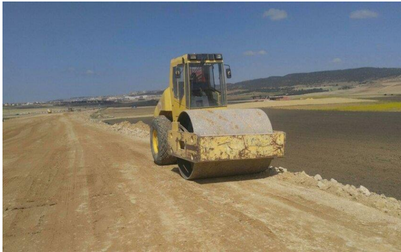
Figure.II.3. Compactage de surface cas d'un projet de chemin de fer [Tiaret.Algerie.2017]
