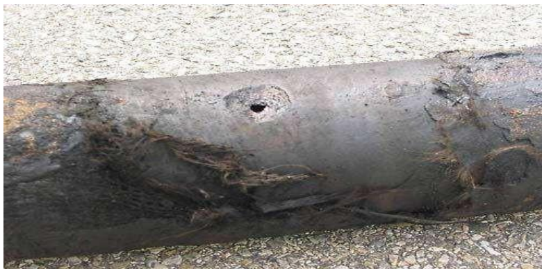
Figure 1.4 : Corrosion par caverneuse [19].
