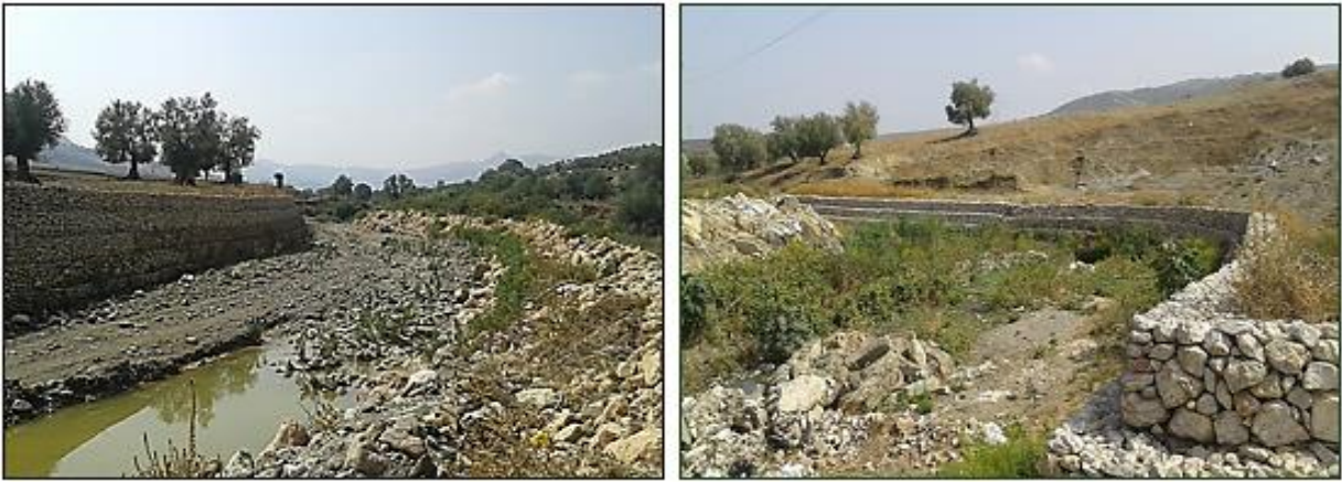
Figure 4.14. La réalisation de l'aménagement d'une partie de L'oued Enssa.
