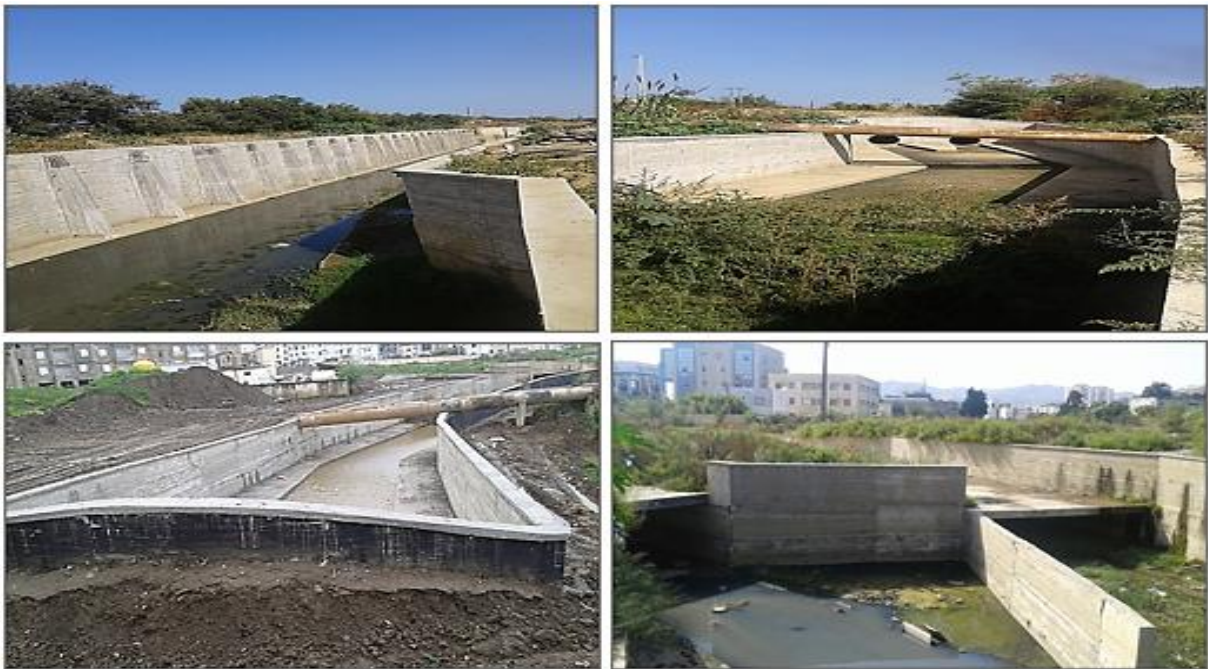
Figure 4.11. La réalisation de l'aménagement de chaabet Merdj Eddib à Skikda. (Source : DRE Skikda,2017).
