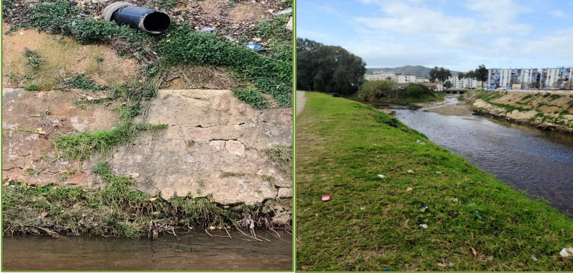
الشكل I 2: صورة لمياه الصرف الصحي لمدينة سكيكدة.
