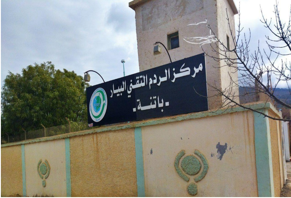
الشكل (III-1) : مركز الردم التقني بباتنة البيار
