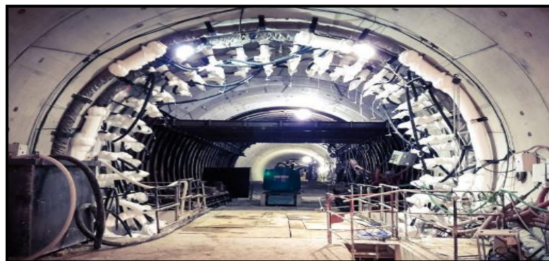
Figure II.2 Traitement du sol par congélation en France.
