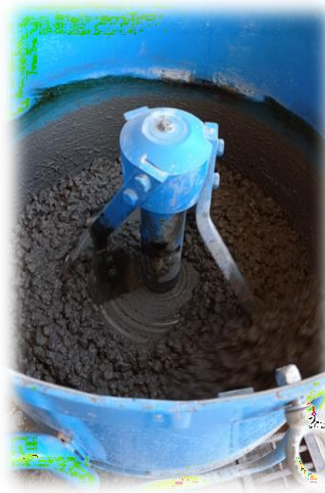
Figure III- 21 : Le malaxage de béton [LTPE, 2024]
