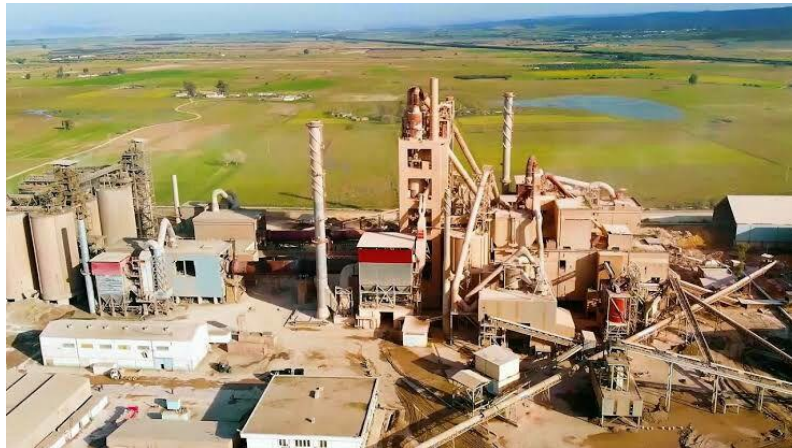
Figure II.1. Société de cimenterie de Hadjar-Soud (SCHS) [53].
