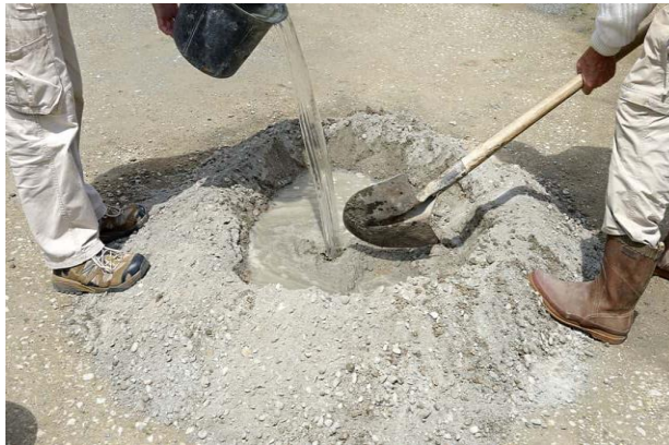
Figure I.6. Préparation manuelle du mortier [23].
