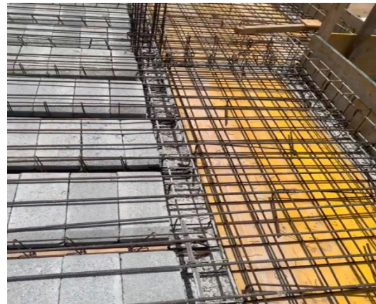
Figure IV.16 a) b) : Plancher à dalle pleine [19].
