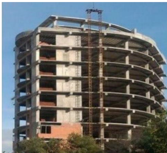
Figure II.1 : Structure en réel avec contreventement parasismique [29].
