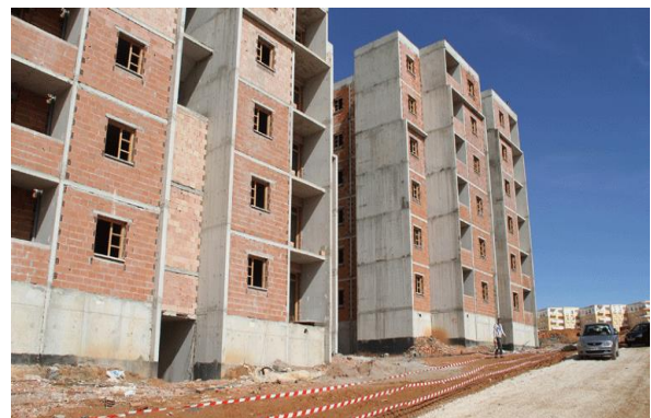
Figure II.6 a) b) : Structure mixte composé par des voiles porteurs couplés à des portiques [28].
