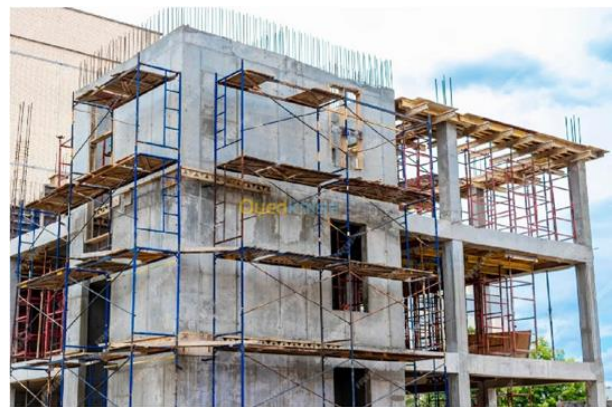
Figure II.4 a) b) : Structure constituée de voiles porteurs en BA uniquement [28].
