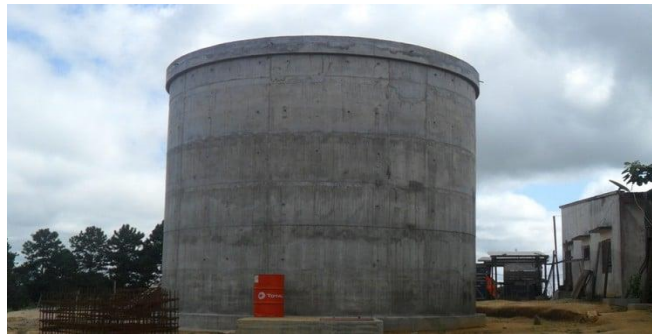
Figure II.7 : Ossature avec console (réservoir d'eau cylindrique) [33].
