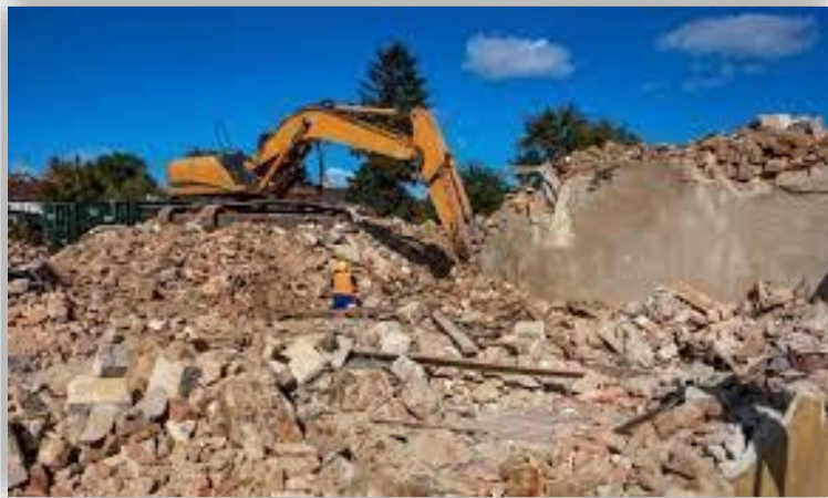
Figure 8: Déchets de démolition.
