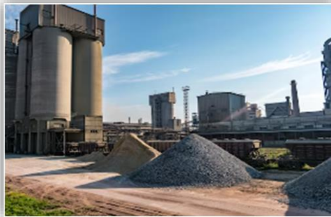
Figure 10: Industrie du béton.
