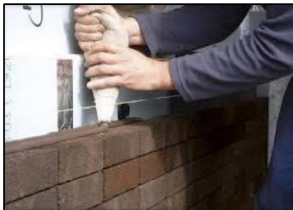
Figure I.5: Les joints de maçonnerie [H.Alipacha. M.Boukerdel].
