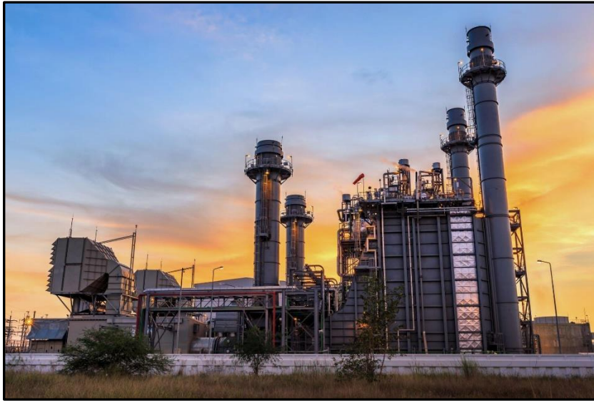
الشكل 1.2: محطة لتوليد الطاقة الكهربائية باستخدام الغاز الطبيعي.
