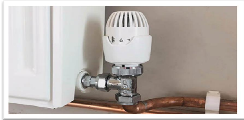
الشكل 7. صمام المشع الحراري الثرموستاتيكي.
