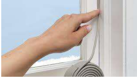
شكل 8.I. طريقة عزل النوافذ.
