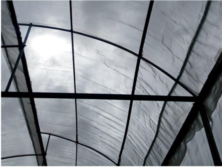
الشكل 1.1. 14 القبة المركزية للبيت البلاستيكي.
