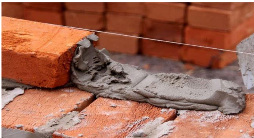
FigI.7: Pose de mortier de hourdage.
